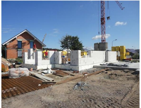
Kelleraußenwände Stahlbeton mit 28 cm Polystyrol. EG in Massivbauweise aus Porenbeton-Plansteinen mit 16 cm WDVS aus Polystyrol. OG in Holzständerbauweise mit Zellulose-dämmung und WDVS aus Holzfaserplatten. Walmdach mit Zellulosedämmung und Unterdach aus Holzfaserdämmplatten. 3-Scheiben-Wärmeschutzverglasung mit  $U_w$  0,8 W/mK
