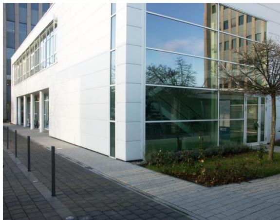
Stahlstützen mit Stahlbetondecken, vorgehängte Pfosten-Riegel-Fassade, Sandwich-Isowand
