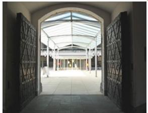
Stahlkonstruktion mit Glasdach als Verbindung zwischen Instituts- und Hörsaalgebäude
