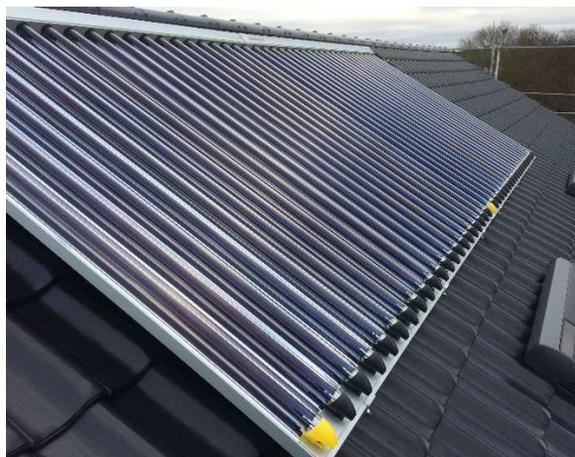
Ersatz von Gasheizung durch Gas-Brennwerttherme mit Solarthermie für Warmwasserbereitung und Heizungsunterstützung.
