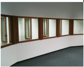
Im 2. Obergeschoss des Hörsaalgebäudes wurden drei Räume zu einem Seminarraum mit 9 zugeordneten Dolmetscherkabinen umgebaut. Dabei waren die besonderen Schallschutzanforderungen für den Bau von Dolmetscherkabinen zu berücksichtigen. Zur Dämpfung der Raumakustik erhielten Mauerwerks- und Trockenbauwände entsprechende Akustikbekleidungen.
