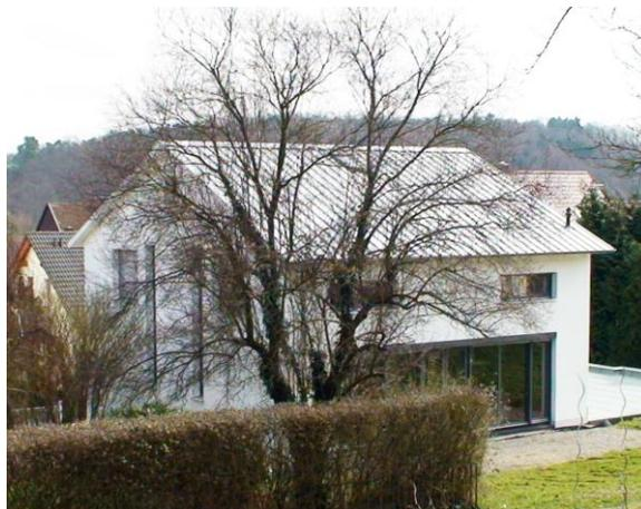
Massivbau aus Kalksandsteinmauerwerk mit 30 cm WDVS aus Polystyrol, Vollunterkellerung innerhalb der Dämmhülle aus Stahlbeton, Abdichtung gegen Erdfeuchte, 30 cm Perimeterdämmung an den Wänden und unter der Bodenplatte, Stahlbetondecken, sichtbares Stahltragwerk im Innern, Satteldach als Sparrendach mit Zwischen- u. Aufsparrendämmung, Trapezblechdeckung, Stahltreppen Hoffer Bauart
